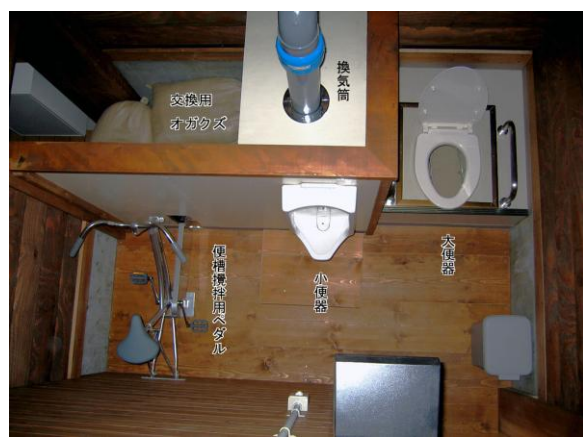
トイレ内部状況
