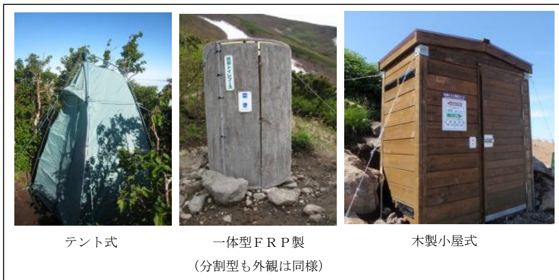
写真1. トイレブース各種外観
