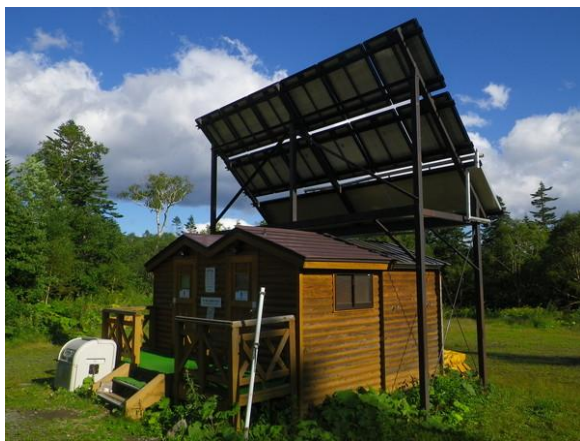
(写真 42) 短縮路登山口のバイオトイレ全景 と回収ボックス
