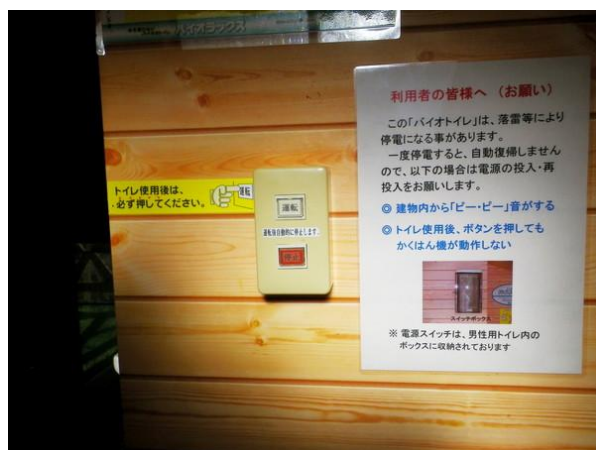
(写真 47) トイレ使用後はスイッチを押し便槽 内を自動で回転させる
