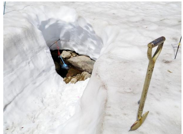
（写真2）水場は何回か試掘をし、1日で掘り上げたとのこと
