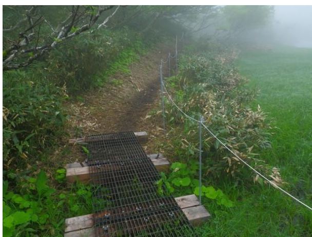
(写真 41) 羅臼湖登山道整備に所々グレー チング工法が敷設されている
