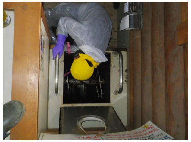
(写真12) 便槽の汲み取り作業
