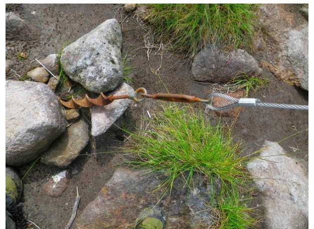
（写真 31） ブースの位置は強風が吹くので アンカーはスクリュウで固定して ある
