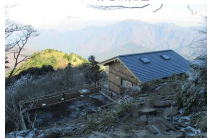
土壌処理槽・建屋全景
