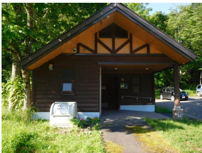
(トムラウシ園地公衆トイレ)
