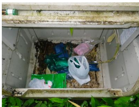
（写真2） 底が抜け、缶が生えている
