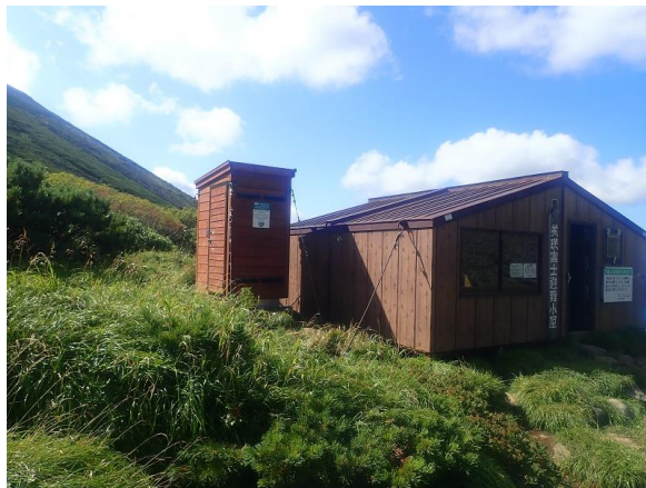
新設された固定式携帯トイレブース
