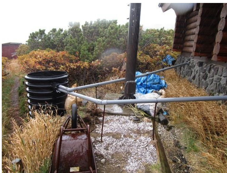
特殊桝の設置状況
