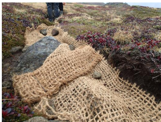
写真 12 ヤシネットによるマット施工
