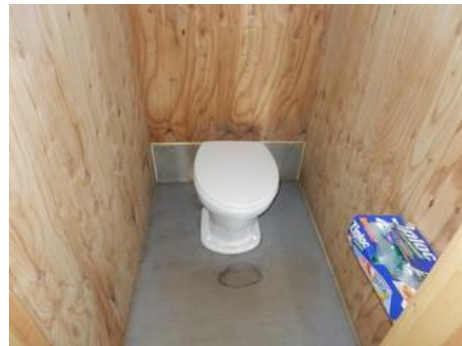
羊蹄山避難小屋トイレ
