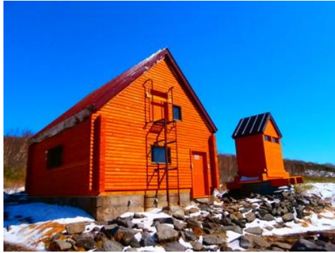
大規模改修されたヒサゴ沼避難小屋（2019 年）
