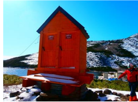
トイレは上屋だけ改修（2019 年）
