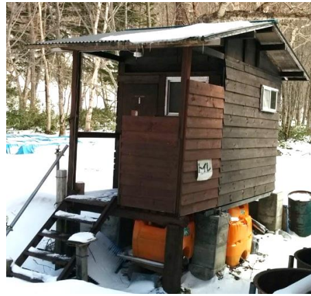
工事前のトイレ棟(2016 年) 下は便槽用のローリータンク
