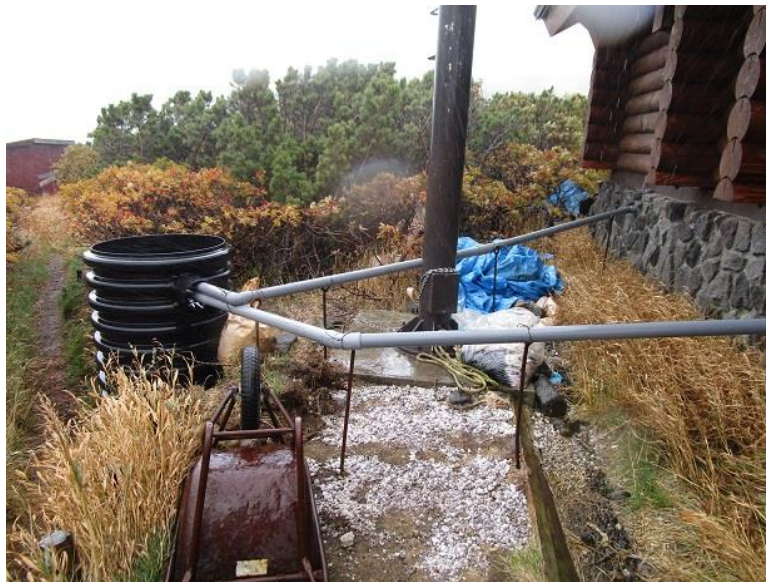
特殊桝の設置状況
