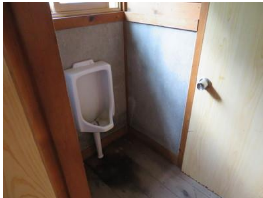
小便器室のドアを開くと共用和式トイレ
