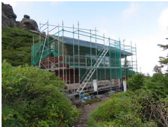
大規模修繕の工事中でした
