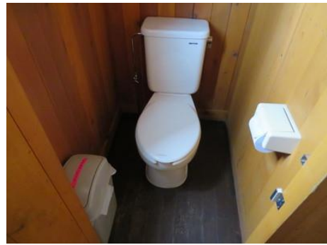
男子大便室（トイレ紙回収箱がある）
