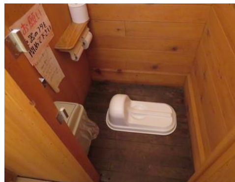
和式便座（トイレ紙回収箱がある）
