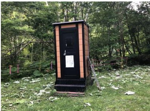
簡易水洗の仮設トイレ
