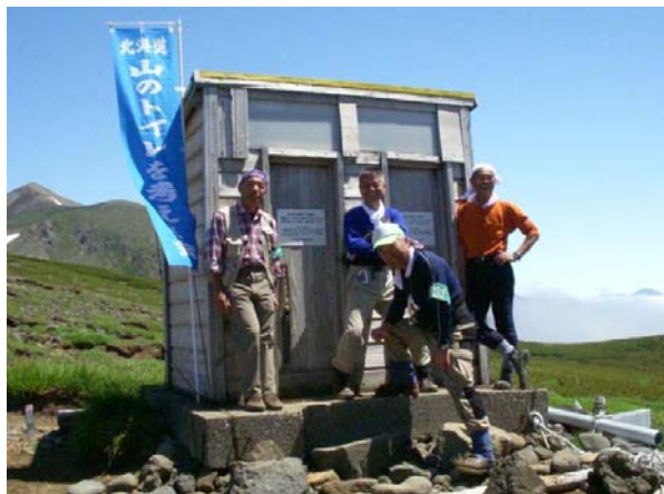
上ホロ避難小屋トイレでの注意掲示板取付
