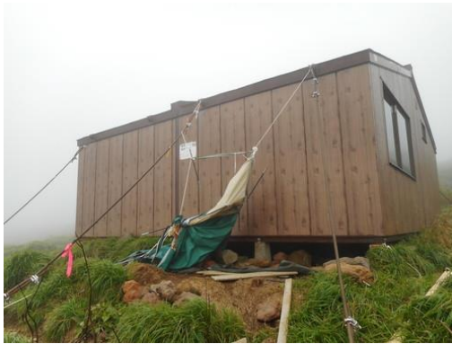
倒壊した携帯トイレブース（9月2日）
