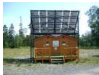
トムラウシ山登山口でのバイオトイレ (ソーラー式)
