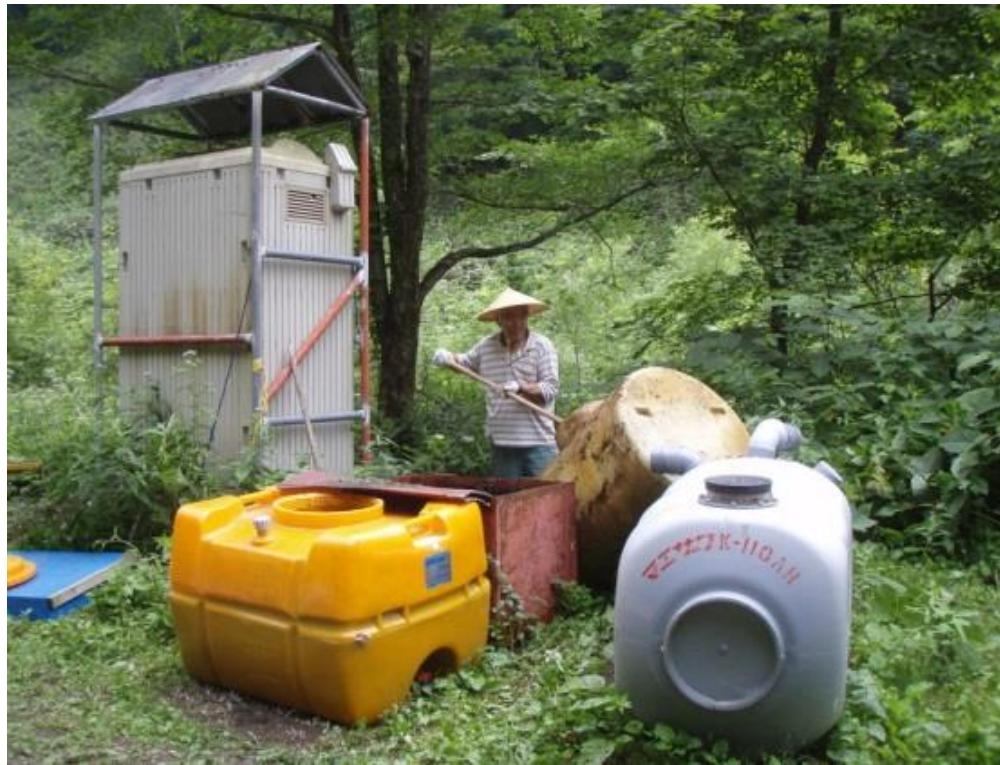
登山口の簡易トイレ。バキューム運搬のため仮保管槽へ排泄物を移し替える
