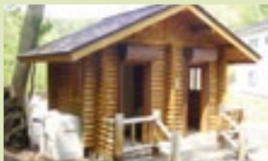
「木下小屋」前のトイレ
