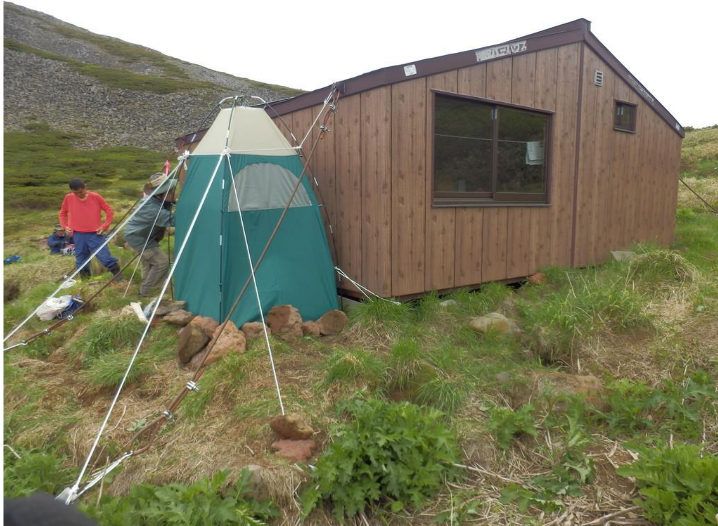
テント型仮設携帯トイレブース設置
