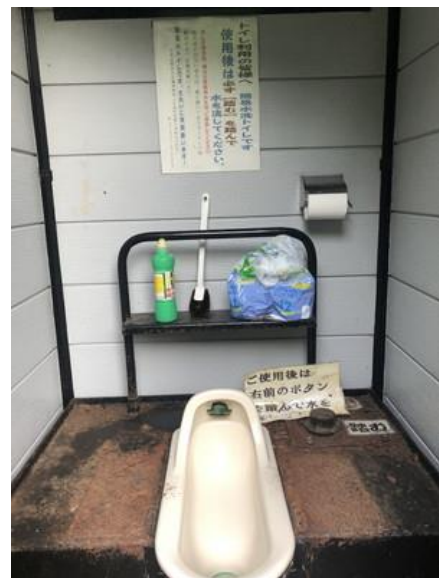
清掃用具と右に足踏みポンプがある
